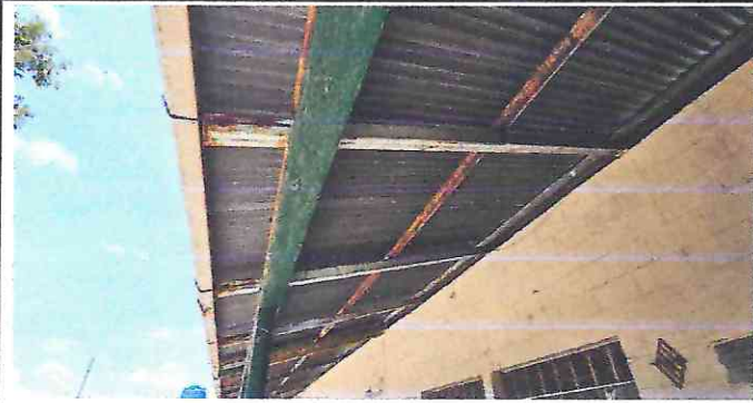
Foto 3, Sustitución de canal liso en mal estado
