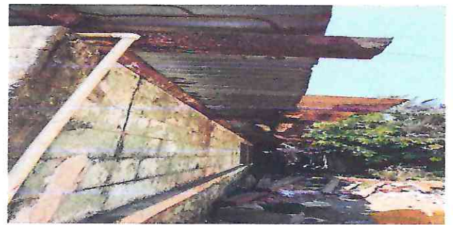
Foto 4, Sustitución de canal liso por tubo pescante de 4X4
