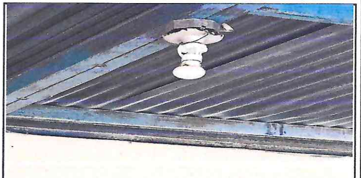
Foto 6. sustitución de instalación electrica
