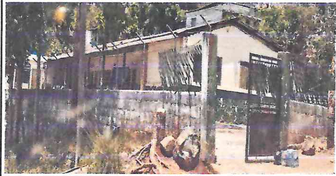
Foto 1: Cambio de lámina por deteriorado
