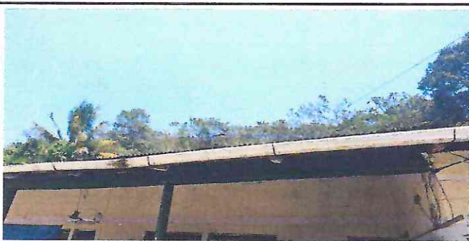
Foto 5, sustitución de canales de pvc colonial y bajadas
